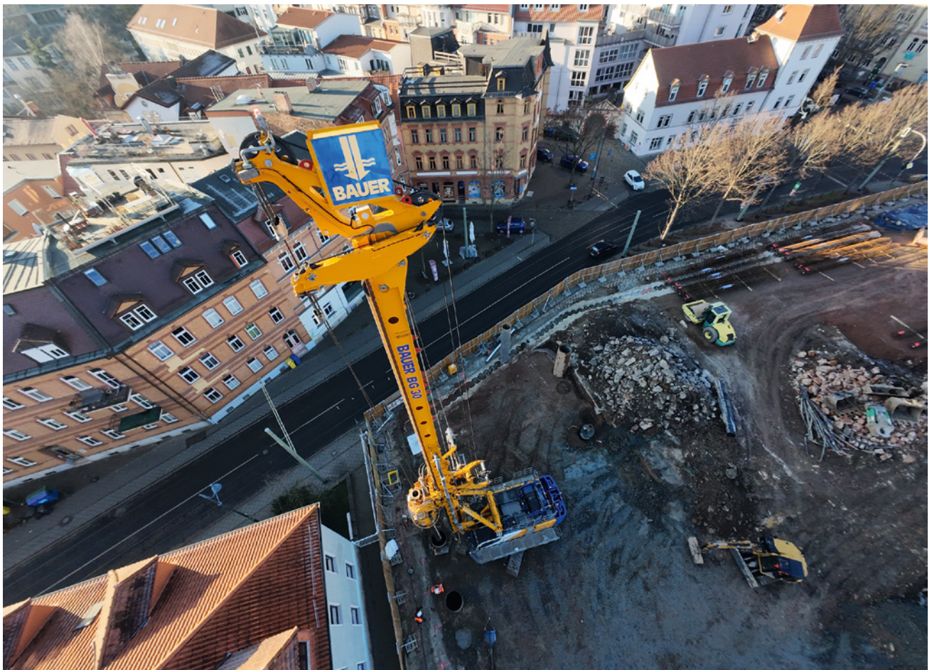
Abb. 9+10 Geothermie-Stahlpfähle (oben) und Geothermie-Bohrgerät
