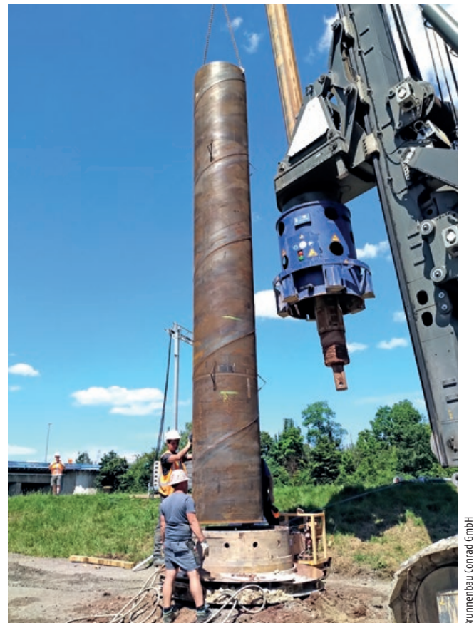
Abb. 7 – Einbau Sperrrohr DN 100
